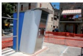
La struttura è dotata di un pannello erogatore per riempire di acqua a temperatura ambiente, refrigerata o frizzante le bottiglie, che potranno essere riutilizzate più e più volte. Lo scopo infatti è proprio quello di ridurre la quantità di rifiuti prodotti, ed in particolare di plastica, ma la fontana consentirà anche di risparmiare sul costo dell'acqua dal momento che verrà applicata la tariffa di 5 centesimi ogni litro e mezzo.
