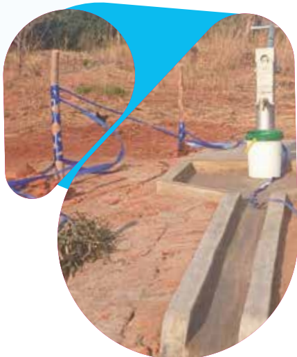
Realizzazione pozzo in Malawi
