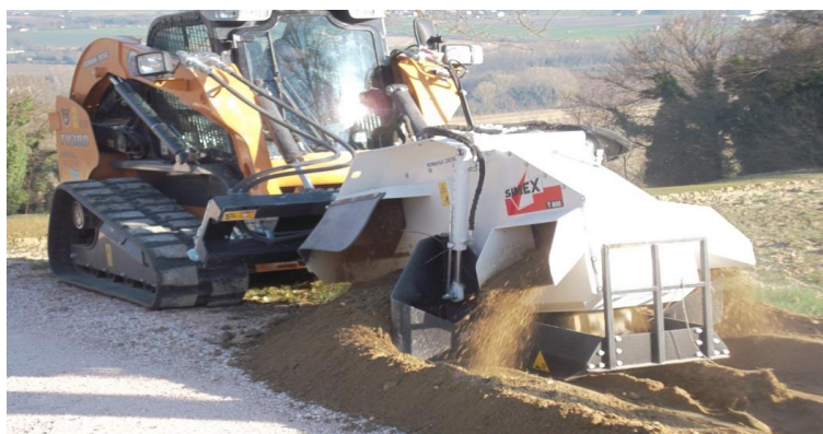
Macchina operatrice al lavoro
