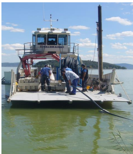
Posa in opera condotta
