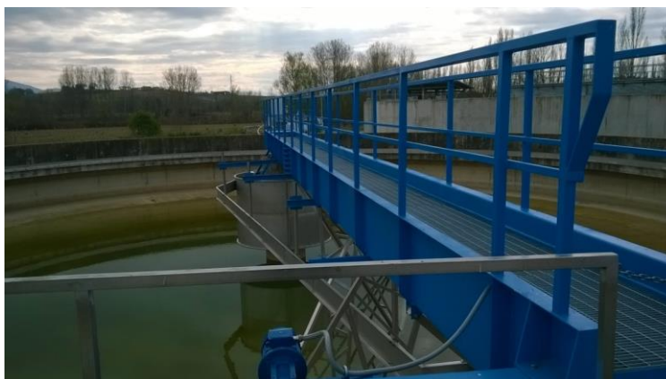
Lavori impianto di depurazione di Ponte Valleceppi - Perugia
