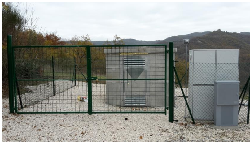
Particolare nuova area pozzo – loc. Carpini Montone
