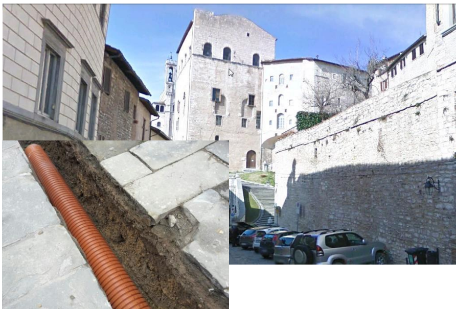
Intervento su linea fognaria in via Savelli della Porta - Gubbio
